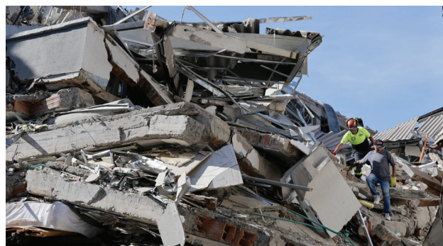
Una búsqueda contrarreloj. Rescatistas recorren cuidadosamente los restos de un edificio destruido mientras avanzan los esfuerzos para localizar posibles sobrevivientes.
