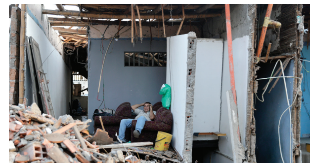
Lo que queda de un hogar. Un hombre permanece sentado entre las paredes destruidas de una vivienda, una imagen que refleja el impacto humano de una tragedia que dejó a numerosas familias frente a enormes pérdidas.
