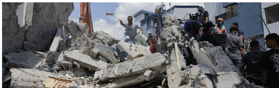
Rescate entre los escombros. Equipos de emergencia y voluntarios trabajan entre los restos de una edificación colapsada tras el fuerte terremoto que sacudió Colombia.
