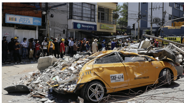
Las huellas del terremoto. Un taxi destrozado y grandes bloques de concreto sobre la vía reflejan la violencia con la que el sismo golpeó las zonas afectadas de Colombia.
