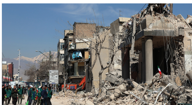
Edificios dañados y escombros en una zona urbana de la capital iraní reflejan el impacto de los ataques aéreos en áreas cercanas a instalaciones estratégicas. Las autoridades iraníes han denunciado daños significativos en varias ciudades mientras continúan las tensiones militares.
